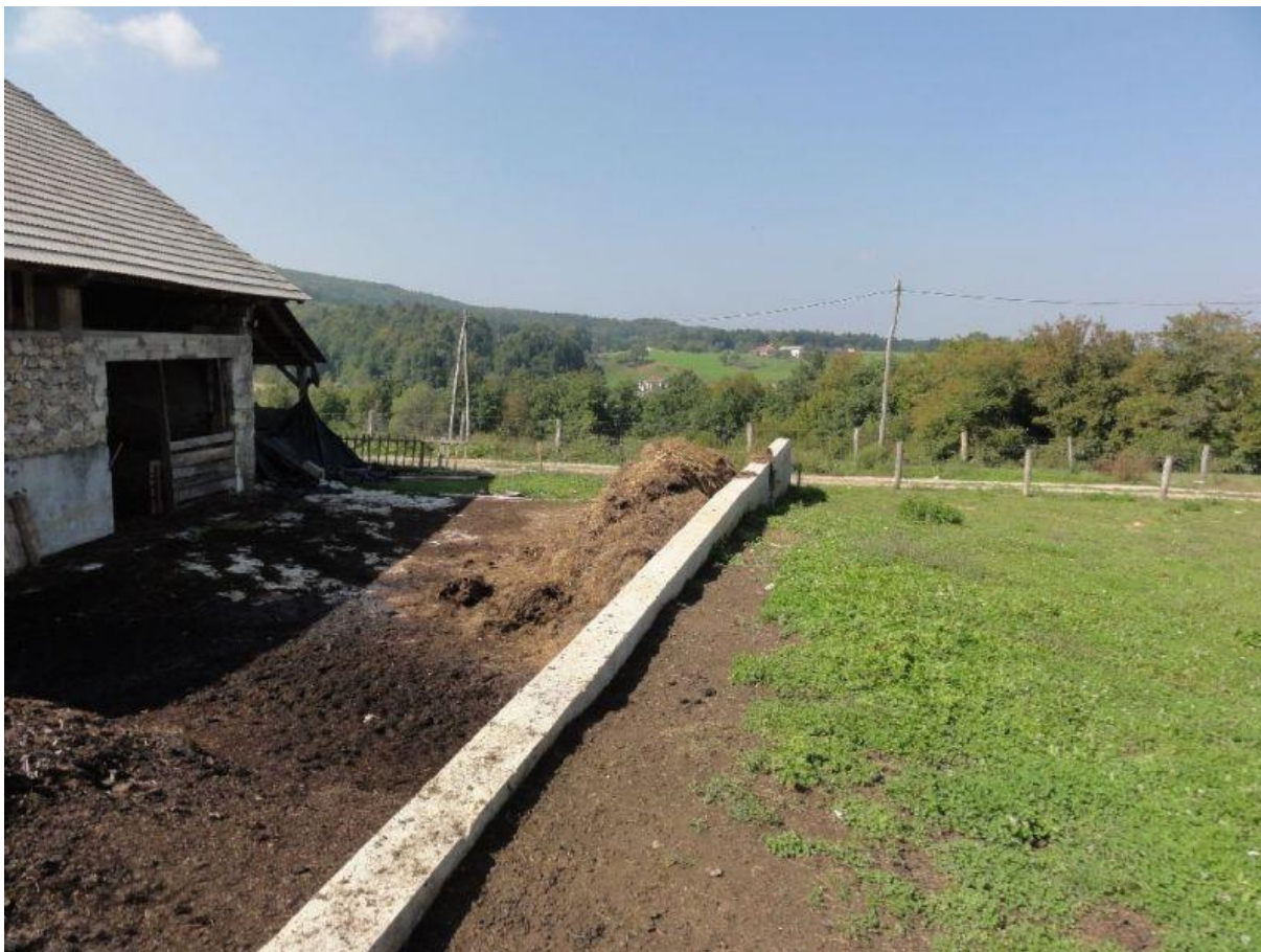
Slika 131: Zidano gnojišče ob hlevu
